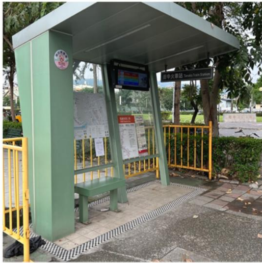
圖9 臺鐵田中站公車候車亭
