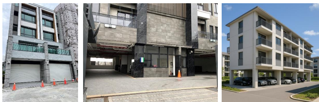
圖 1.5 架空層集合住宅空間型態 （一樓架空停車層、採自然通風、低公設比，結構形式具開放性） （資料來源：本研究實地拍攝(2025)）
