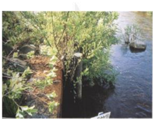
圖 4-3-9 樁木柴柵柵工法綠化後 1
