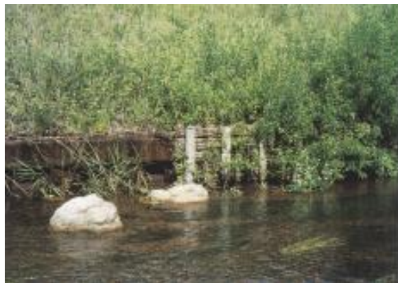
圖 4-3-10 樁木柴柵柵工法綠化後 2
