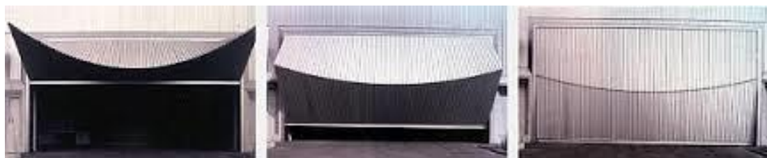
圖 四 卡拉特拉瓦設計的車庫大門(Ernsting Warehouse)的開闢機制
