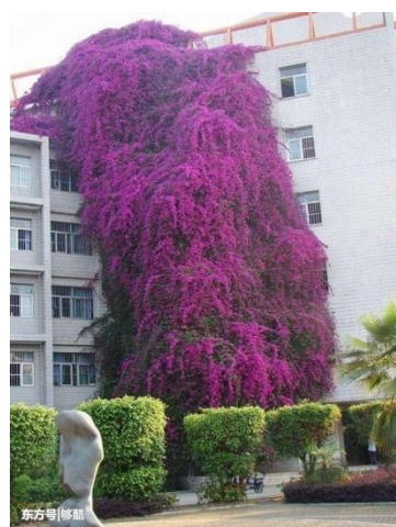
圖 4-1-3 被植栽埋沒的建物
