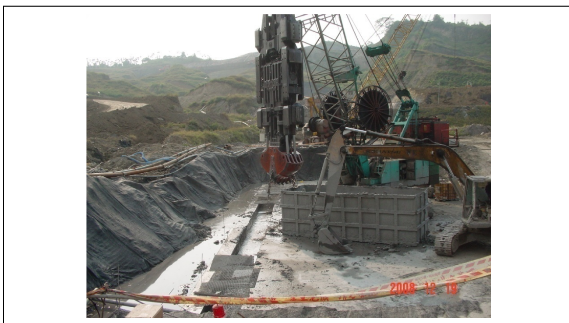
圖 3-5 截水牆施工機具
