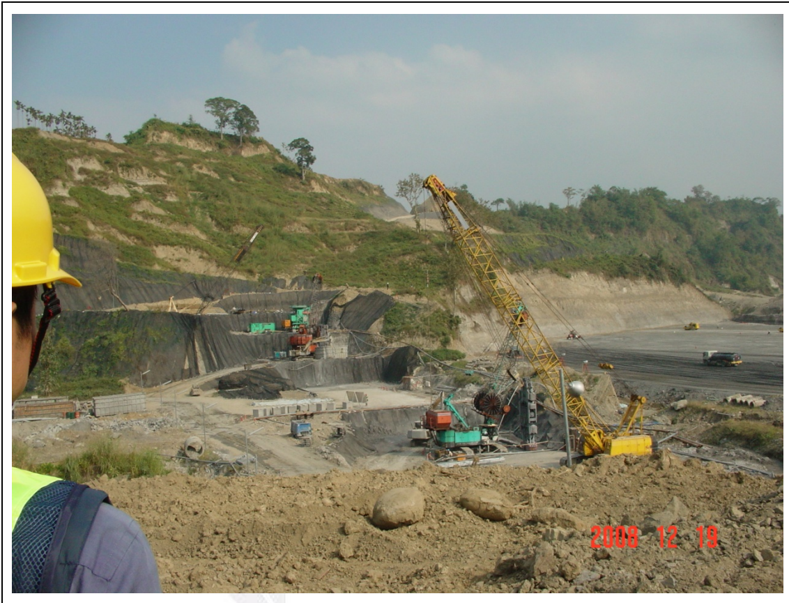
圖 3-3 截水牆施工機具
