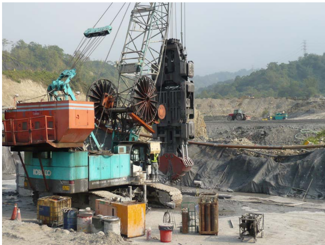
照片 4 截水牆施工情況
