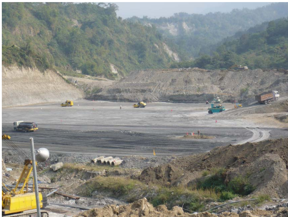
照片 3 滾壓式壩體施工情況
