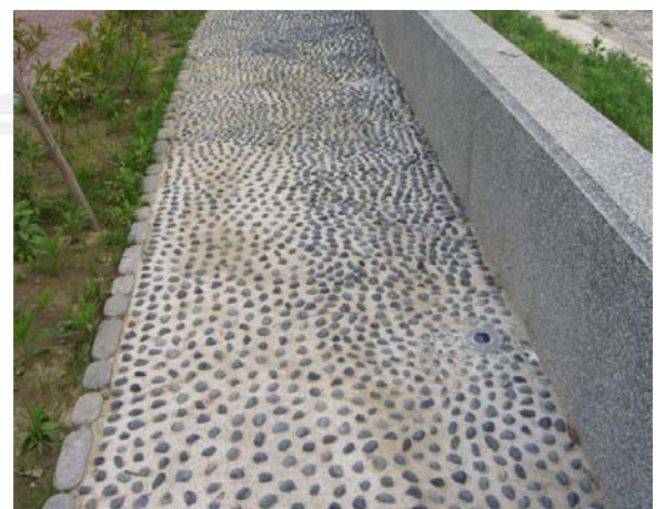
照片 14: 堤防旁的人行車道
