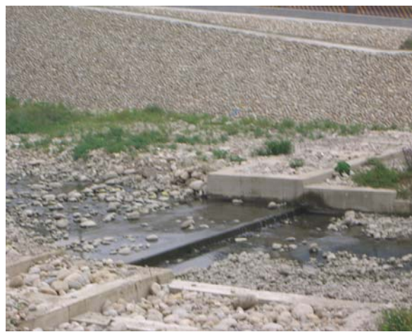
照片 21: 固床工 (河工結構物)
