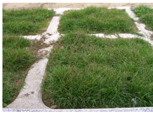
照片 8: 植生框設計四方形圓角, 研發製作鋼模, 使造型矮牆與戲台之間連接平順。
