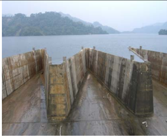
圖 O. 溢洪道水工模型鋸齒堰
