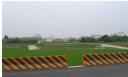
照片 6: 紐澤西護欄(底部為實心)
