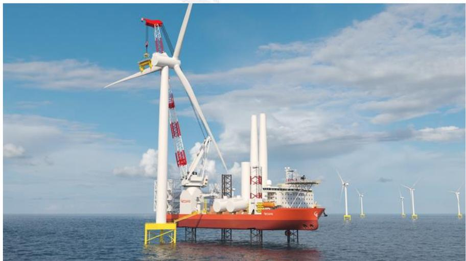
圖 2 自升式平台船施工情形
